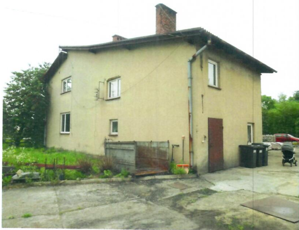
Widok na wyceniany budynek
