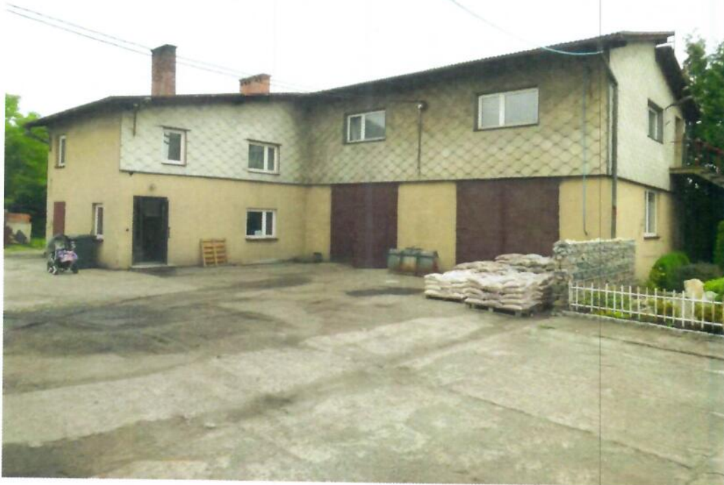
Widok na wyceniany budynek i wejście nr 2
