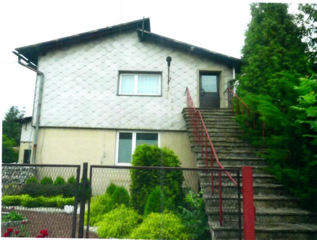
Widok na wyceniany budynek ze schodami zewnętrznymi
